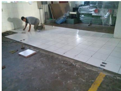
Remodelación de sala
